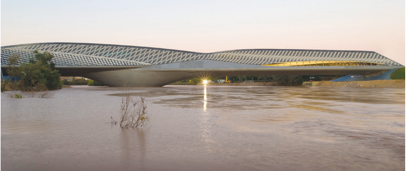
Construcció en què ha participat Opersis.
